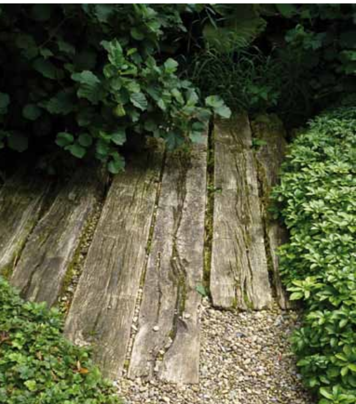
Figuur 4.9.1. Hergebruik van bielzen in een pad of als loopbrug over een vijver. (Triple E) Gebruik onbehandeld hout.
