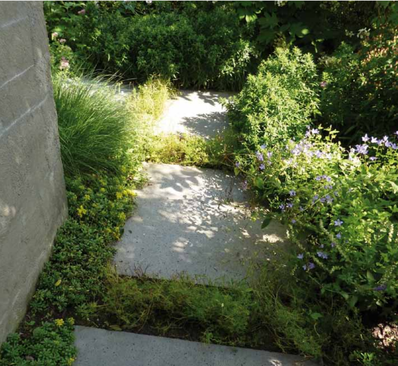
Figuur 4.1.9. Een pad van staptegels met begroeide en open voegen. (Triple E) Infiltratie van hemelwater in de bodem is mogelijk. Pad biedt ruimte aan flora en fauna en is goed voor het bodemleven.
