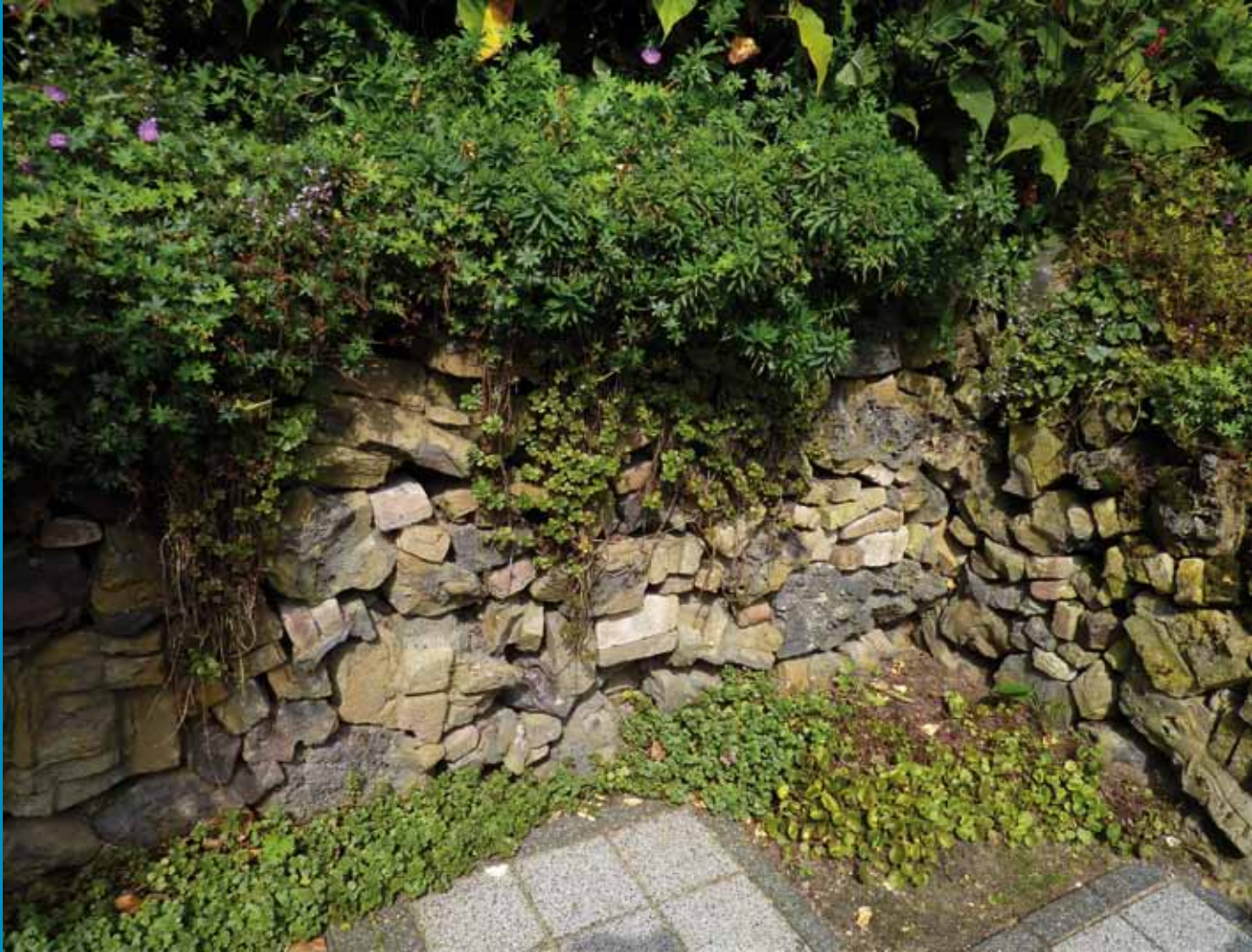
Figuur 4.9.9. Oude stenen in muurtje. (Triple E) Losse hergebruikte stenen met planten ertussen houden het regenwater goed vast.
