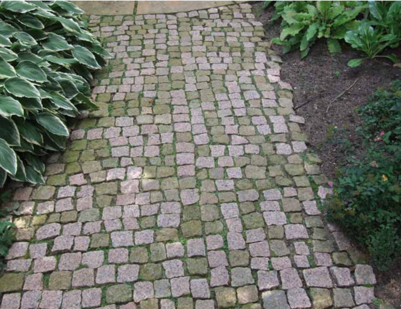
Figuur 4.1.3. Door open voegen kan het regenwater infiltreren in de bodem. (Triple E) Via de voegen kan hemelwater in de bodem infiltreren. Afschot leidt het water naar de borders voor verwerking en dus niet de tuin uit.
