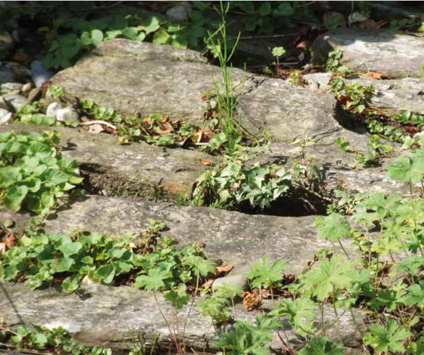
Figuur 4.1.7. Open voegen tussen hout waar planten in groeien, verwerken het regenwater ter plekke. (Triple E)
